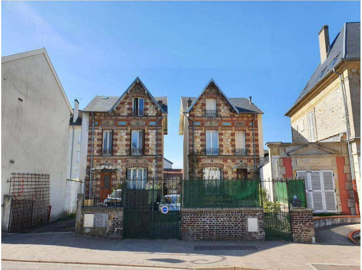
AV80 - 9 rue de la Mairie
